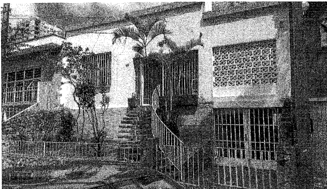
Fachada do Núcleo
