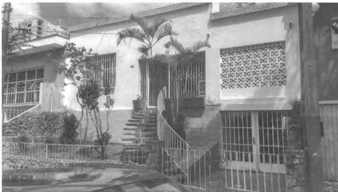
Fachada do Núcleo
