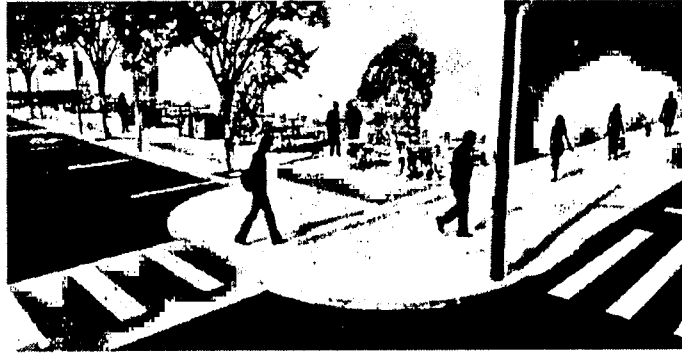
Figura 56: Rampa de Acesso Para Faixa de Pedestres e Lombofaixa (Fonte: Guia Prático Para a Construção de Calçadas)
