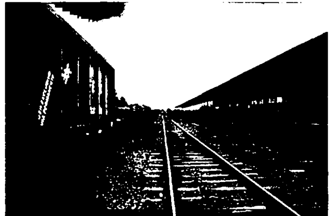
Trecho da Estrada de Ferro Araraquara na antiga estação da cidade.
