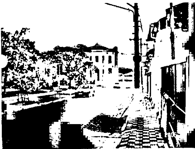
Prédio da Guarda Civil Municipal, prédio da antiga cadeia pública
