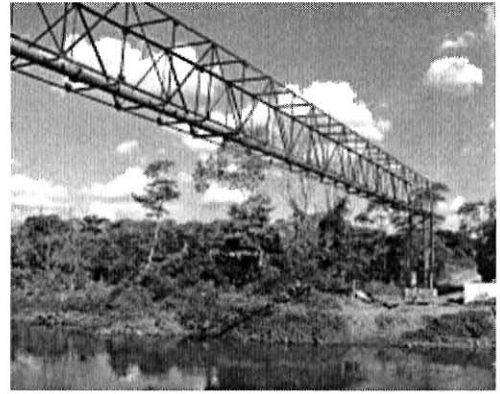
Prefeitura e Saae entregam sistemas de água e esgoto do Parque Industrial da Zona Norte
