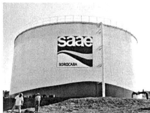
Prefeitura e Saae entregam sistemas de água e esgoto do Parque Industrial da Zona Norte
