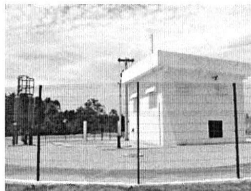
Prefeitura e Saae entregam sistemas de água e esgoto do Parque Industrial da Zona Norte
